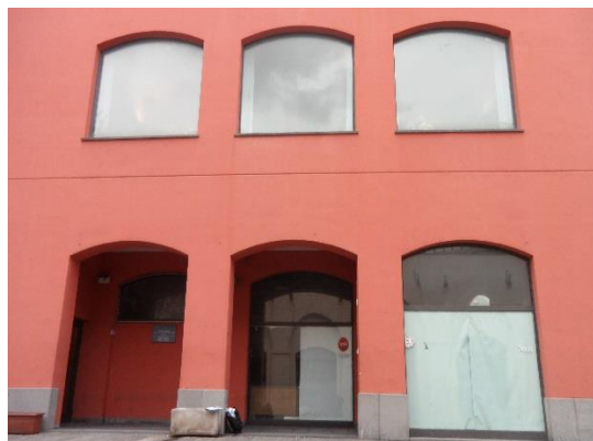
Figura 1.1 - Vista della facciata esposta a Sud-Ovest.
