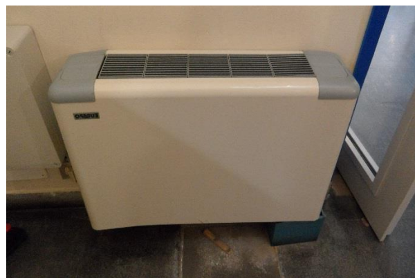
Figura 4.7 – Particolare dei termoconvettori installati nel piano ammezzato
